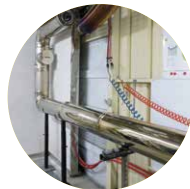
Test di tenuta / Tightness test / Essai d'étanchéité
