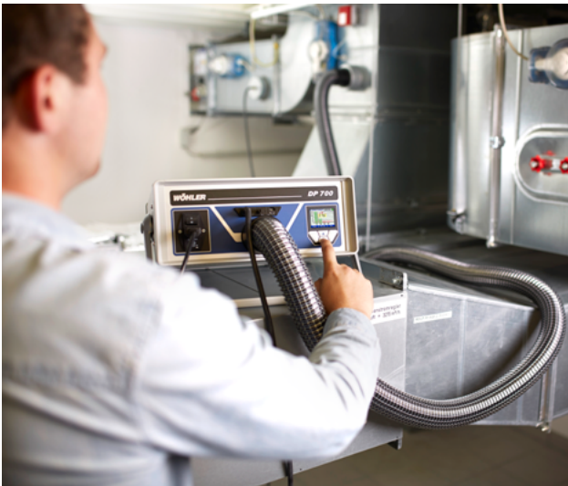
Dichtheidscontrole van geïnstalleerde ventilatiesystemen.
