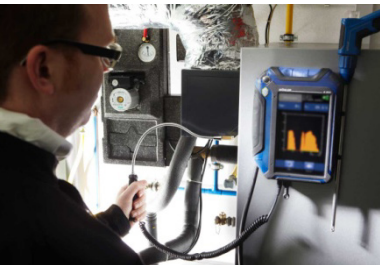
afb. 59: condens zoeken voor terugslagcontrol
